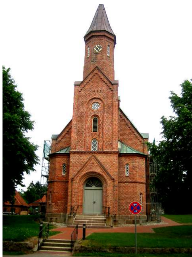
Kirche nach Sanierung des Turms Mai 2006
