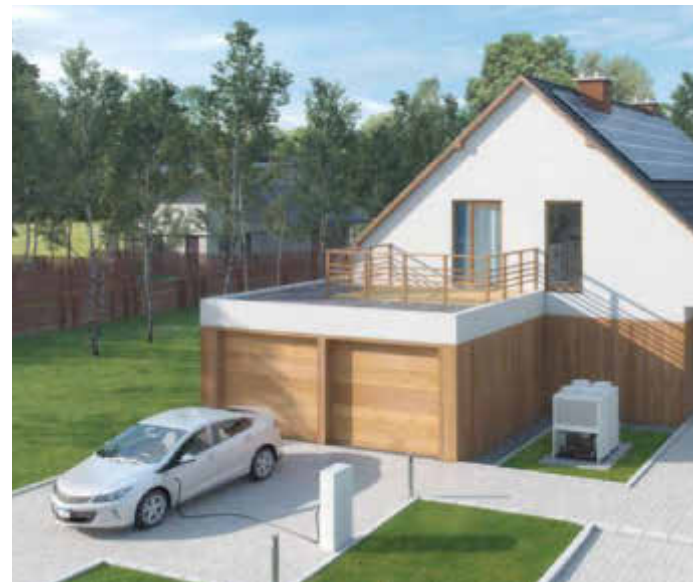
Beim Bau eines neuen Hauses spielt nicht nur der Energieverbrauch, sondern auch die Wahl der Baumaterialien eine wichtige Rolle für die Klimafreundlichkeit. Foto: djd/Copper Alliance/shutterstock
