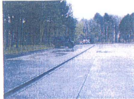
Abb. 12: KVF 10, ehem. Standort Wartungsrampen (16.04.2002)
