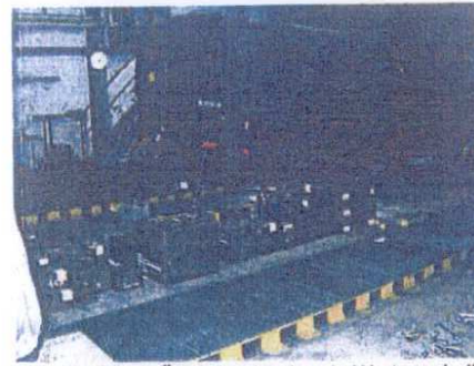
Abb. 7: KVF 4, Ölwechselgruben in Wartungshalle (16.04.2002)
