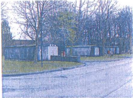
Abb. 11: KVF 7, 8 und 9, Betriebsstofflagerhäuser (16.04.2002)
