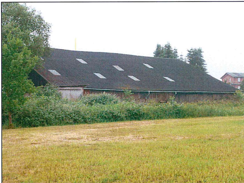
Abb. 04: Mischprobenfläche MP 3, in den Brombeer- und Himbeersträuchern vor dem Haus wurden die Gleise der Loren in ca. 0,2 m Tiefe ermittelt
