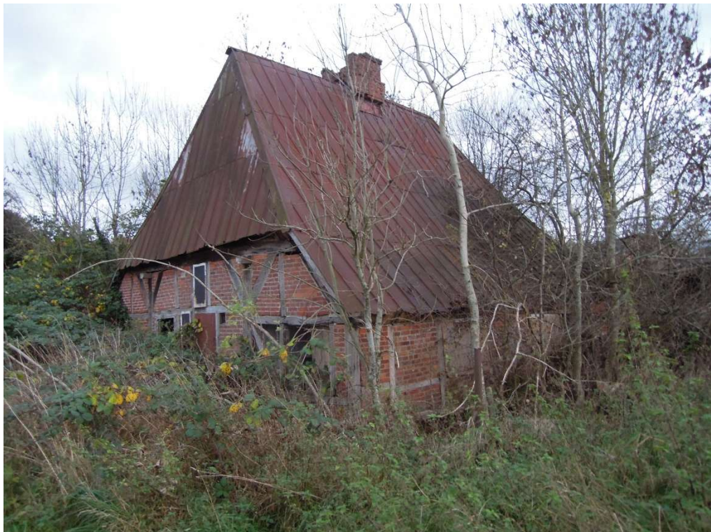
Abbildung 7: Blick von Norden Richtung Südosten auf Laubgehölze, Ruine und Brombeerflur, Foto vom 13.11.2025
