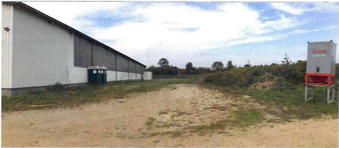
Abb. 4: Vorhabenfläche mit bestehender Reithalle und Knickwall
