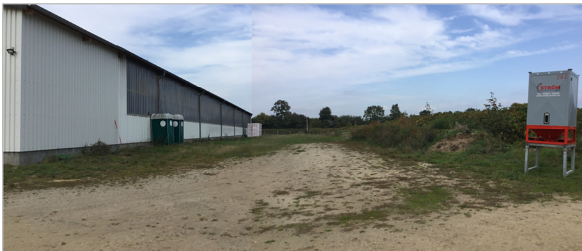
Abb. 4: Vorhabenfläche mit bestehender Reithalle und Knickwall
