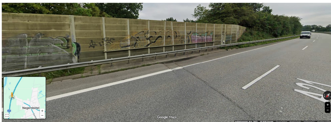
Abb.10 Negernbötel, Dorfstraße 50 Lärmschutzwand Google Streetview 2023
