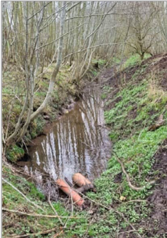
Abbildung 9: Drainagen am nordöstlichen Ufer (Baumgärtner, 23.03.2023)
