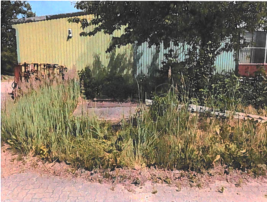
Foto 13: Blick nach Norden auf Brunnenstube Trinkwasserbrunnen
