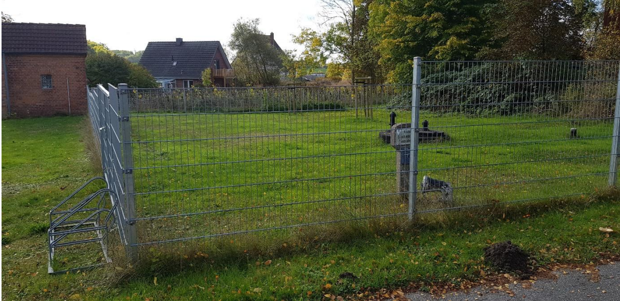
Abbildung 20: Wasserwerk (Quelle: Büro für Bauleitplanung)
