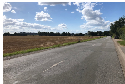
Abb. 11: Bahnhofstraße mit Ackerfläche von Osten
